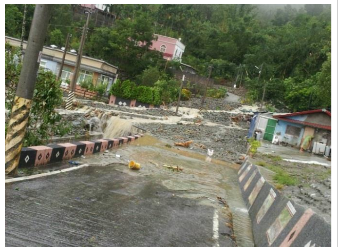
照片12: 大排水溝旁農路也被波及(江子亮先生提供)
