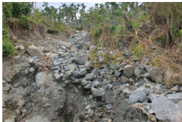
照片4：野溪上游檳榔園崩塌區
