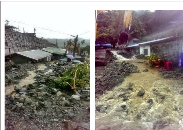
照片9: 排水溝左岸受土石掩埋之三戶房舍(江子亮先生提供)
