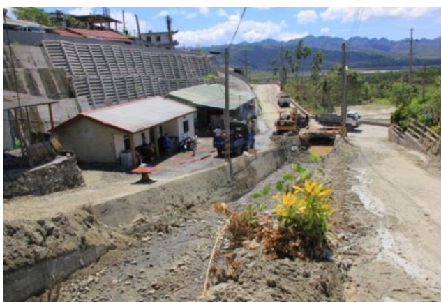
照片25：左岸上邊坡台地聚落
