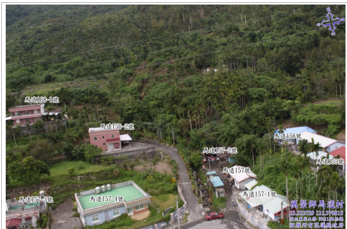
照片1：土石災害發生前無人載具空拍影像99.11月
