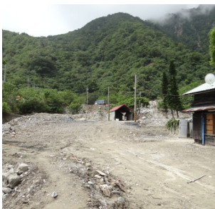
和中聚落遭右側土石流沖入家園之住戶。(和中聚落 100 號)
