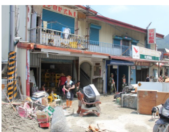
和中聚落中受損嚴重之雜 貨鋪店面。
