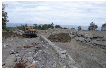
怪手於野溪中緊急疏清土石。
