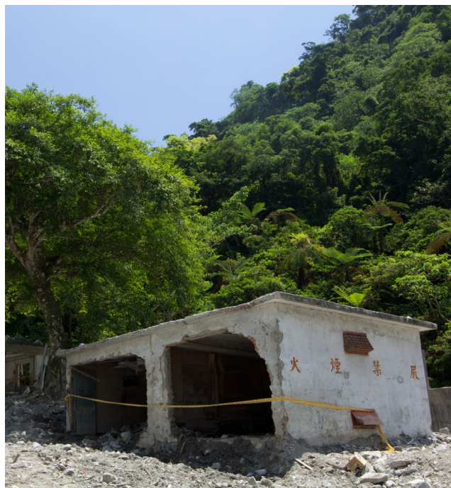
照片 4：原本已被埋入土石中之管理室，開挖後露出全貌。
