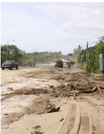
上崇德街道遭土石汙泥沖入(初期清理後狀況)
