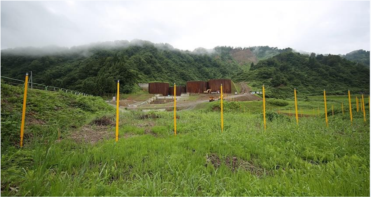
圖五 鋼製圓柱形攔沙壩水流排出情形(資料來源:大地藝術祭)
