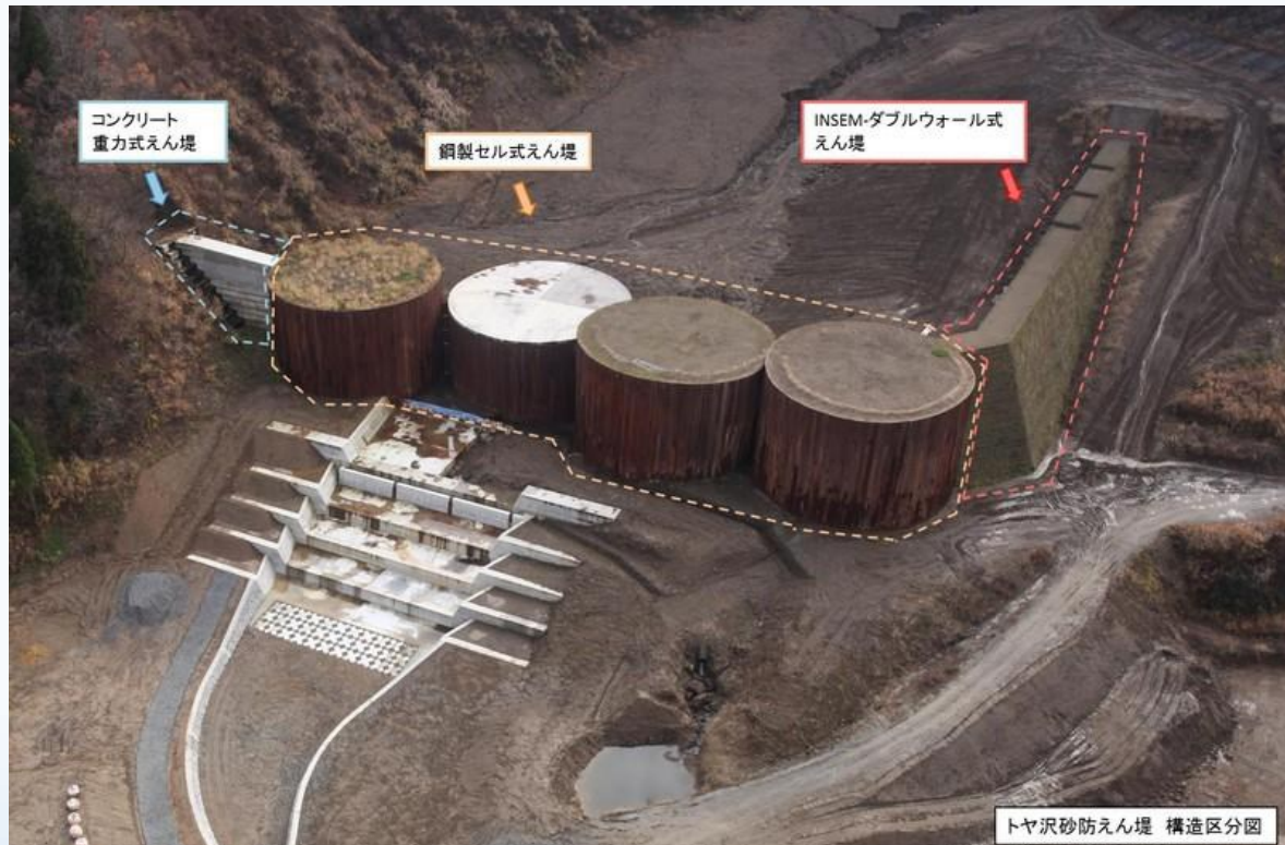
圖四 壩堤結構分析圖(資料來源:新潟縣廳)
